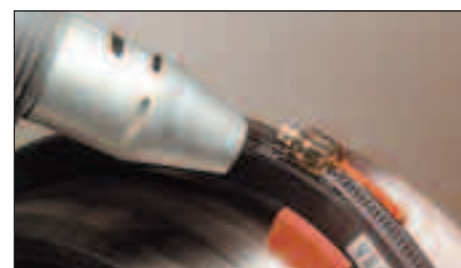
Schritt 4: Den Kleber mit Heißluftpistole aushärten
